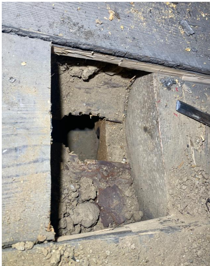
Fot. nr 16. Widok odkrywki stropu (od góry deska, polepa, deska okrągłaki, ślepy pułap, deska otynkowana na trzcinie).
